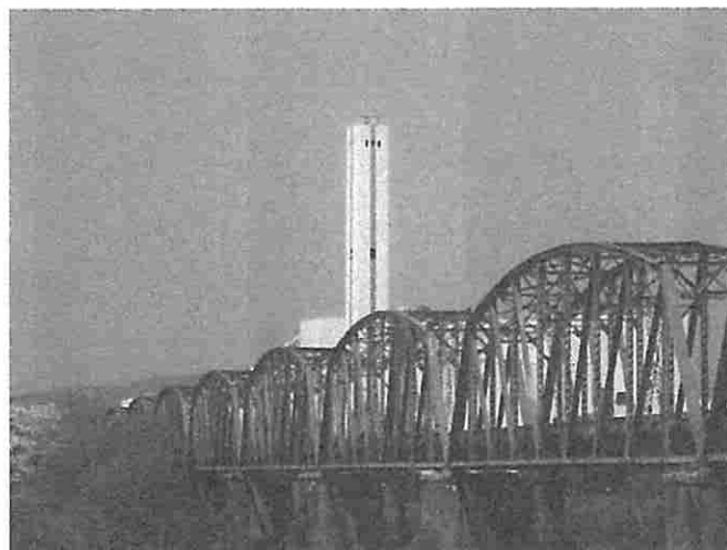
横須賀水道上郷水道管橋
