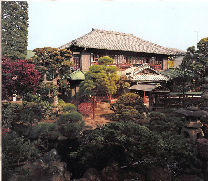
主屋 明治24年(1891年)建築
