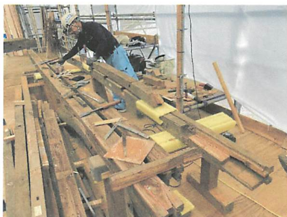
(部材補修の様子)
