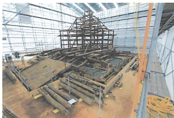
(解体時／軒廻り、小屋組)
