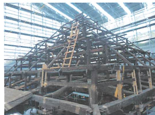
(解体時／小屋組)
